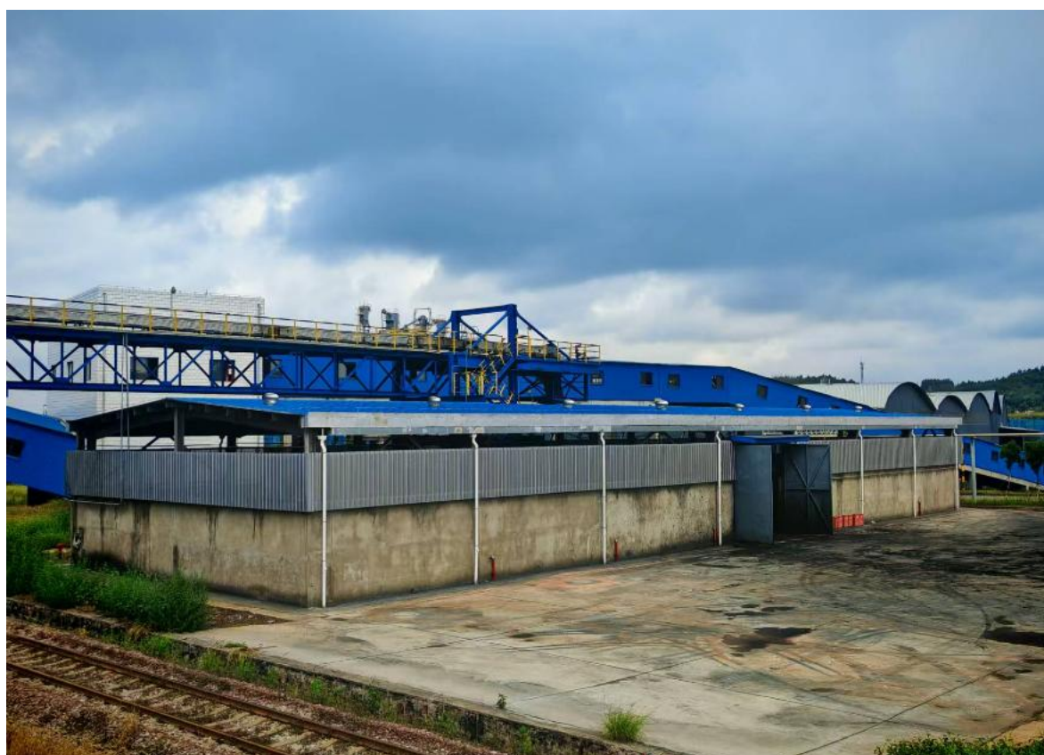
附图 1-4 气化渣 B 库（滤饼库）
